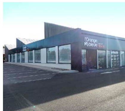
Lieu : Perpignan Équipements installés : VRF, Gainables
