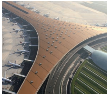
Lieu : Beijing - Chine Unités extérieures : Groupe d'eau glacée centrifuge et groupe d'eau glacée à vis condensé par eau
