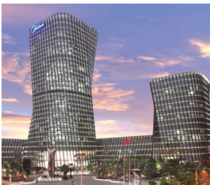
Lieu : Shunde - Chine Unités extérieures : Groupe d'eau glacée centrifuge et groupe d'eau glacée à vis condensé par eau
