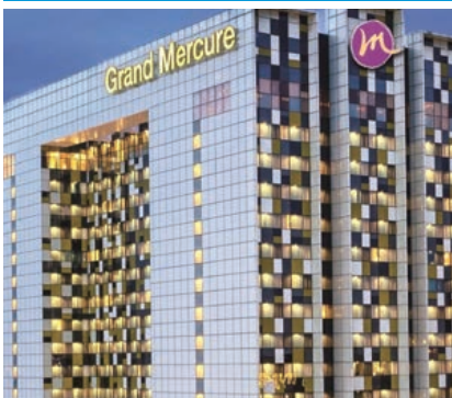
Lieu : Djakarta - Indonésie Unités extérieures : Groupe d'eau glacée centrifuge DC
