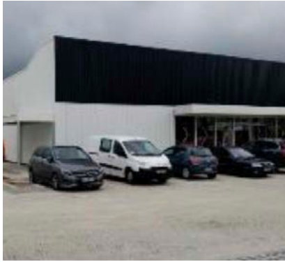
Lieu : La Roche sur Yon Équipements installés : VRF, Gainables
